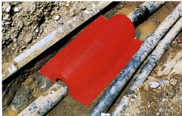
M 70 beim Verlegen M 70 au posage
